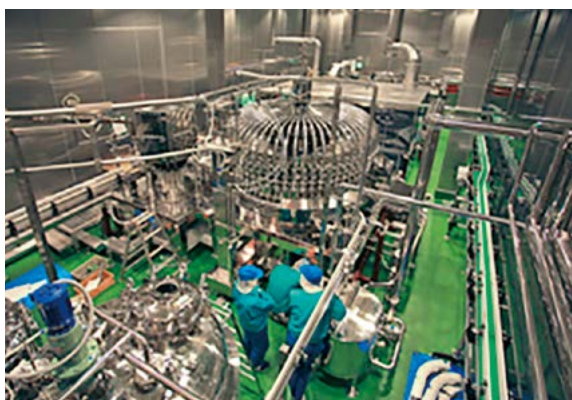
クリーンルームの一例(飲料をペットボトルに詰める室で、空気の高清度を調整する)
